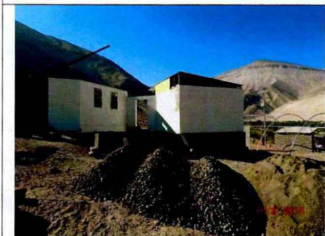
Fotografía N°3: Habilitación recinto para la ubicación de equipos.
